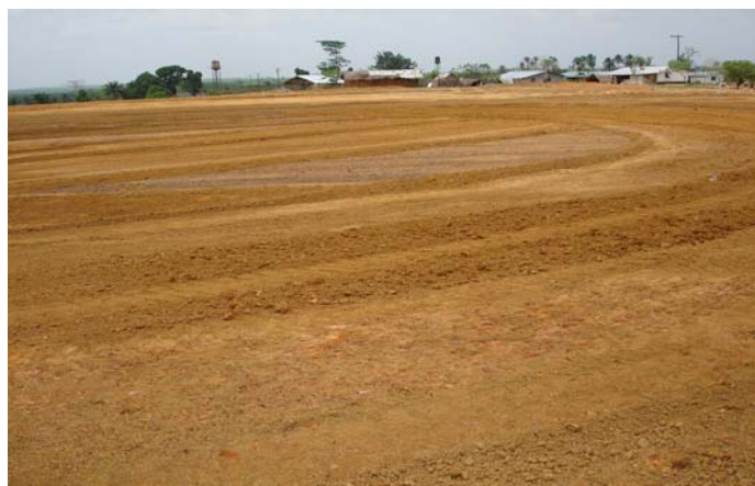
Preparación del terreno para la instalación de césped artificial a prueba de todo clima.
