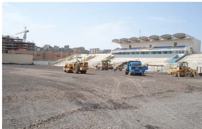
Obras para instalar el césped de fútbol en 2006.
